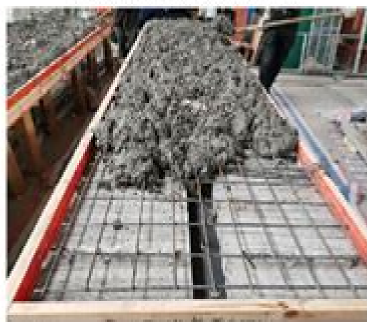
(d) cast-in-place concrete placement
