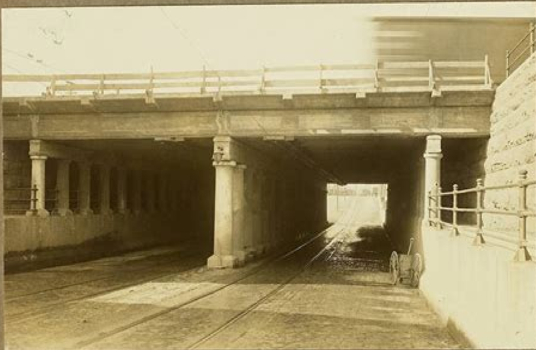
TUNNEL DE LA RUE ONTARIO EST
